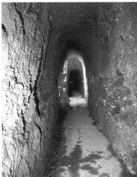
Foto 5 - Cunicoli principali del Divin Maestro: la galleria verso l'ingresso n.3 (foto C. Germani).
